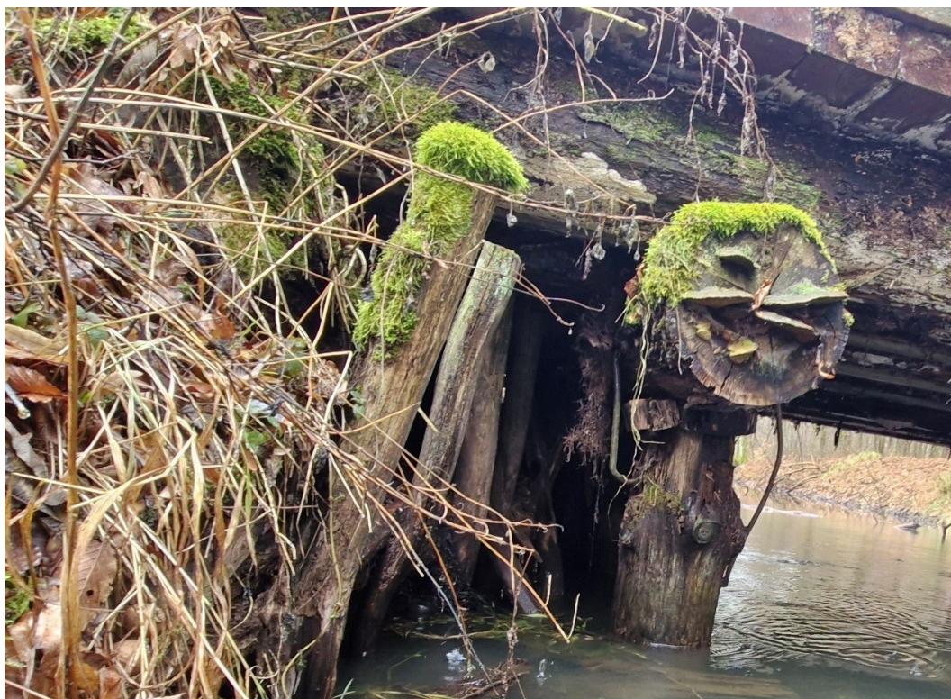
Fot. 14. Podpora lewobrzeżna od strony wody górnej
