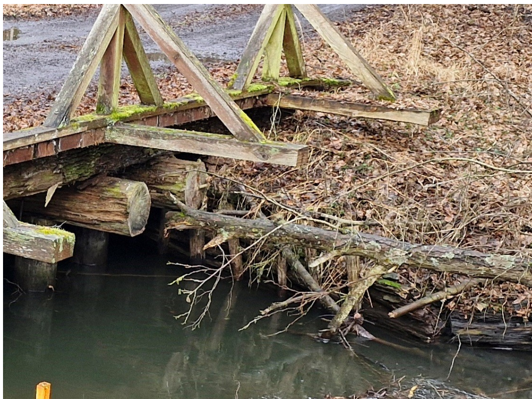
Fot. 15. Skarpa prawobrzeżna widok od strony wody górnej Degradacja umocnień, nierówności terenu, ubytki materiału gruntowego, wegetacja roślinności
