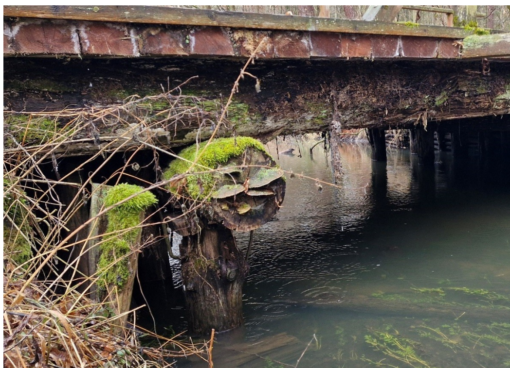
Fot. 9. Dźwigary główne i pomost od strony wody górnej
